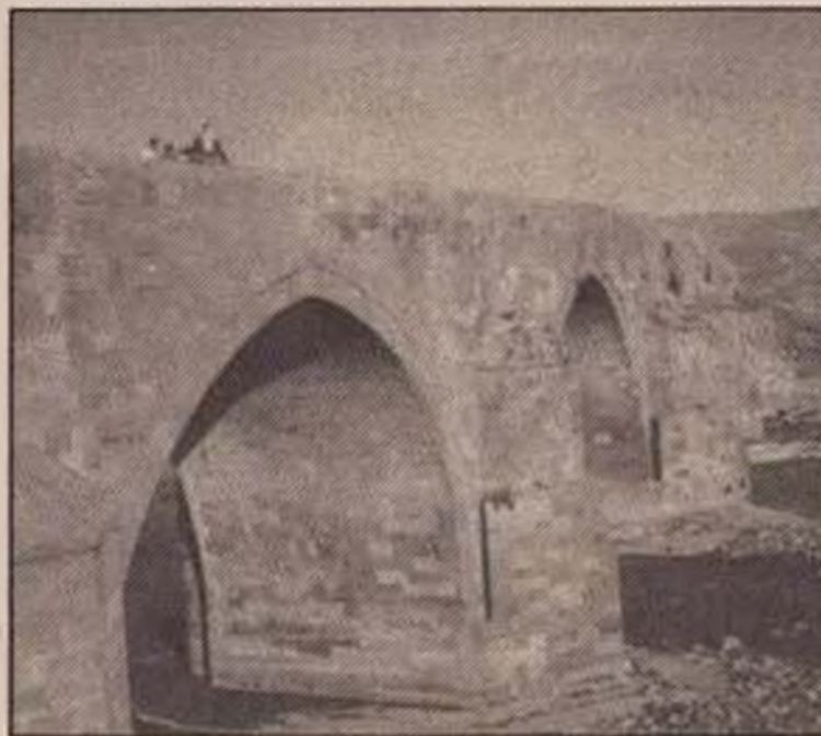
Kağızman-Erzurum yolu üzerindeki tarihi köprü
